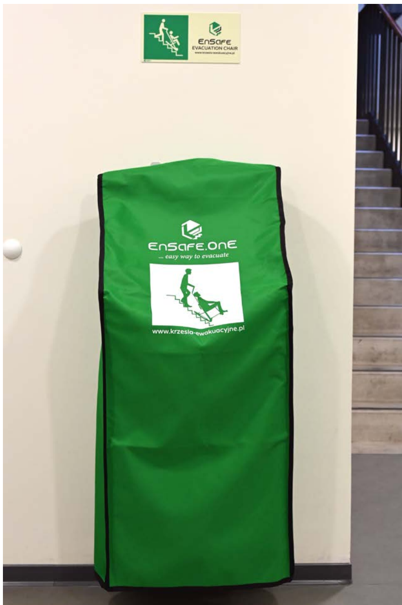
Fot. 1 Miejsce, w którym znajduje się krzesło ewakuacyjne
