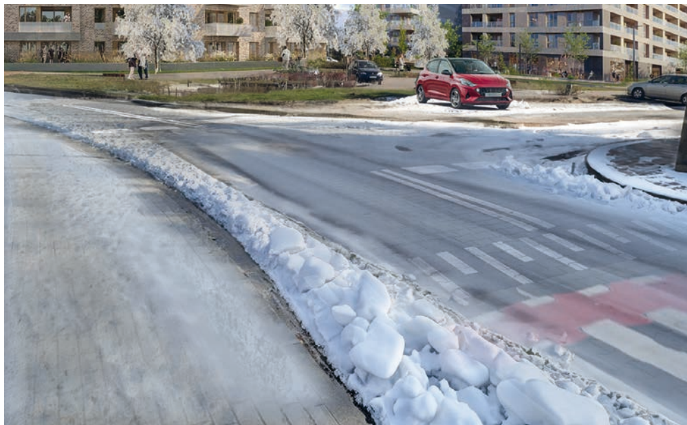
Rys. 7 Nieprawidłowo odśnieżone skrzyżowanie ciągów komunikacyjnych
